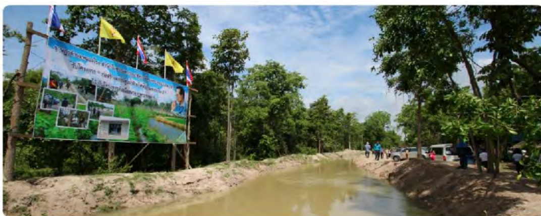
ภาพที่ 35 โครงการสถานีสูบน้ำด้วยไฟฟ้าบ้านหนองโรง 2 อันเนื่องมาจากพระราชดำริ
